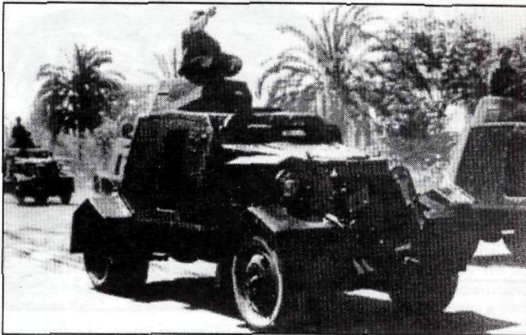
■ Бронеавтомобиль UNL-35 на базе советского грузовика ЗиС-5
